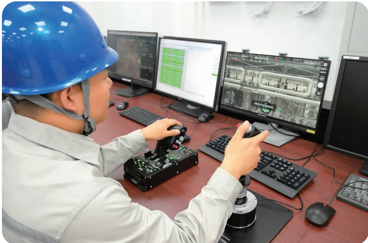
在河北省张家口市张北柔直工程中都换流站，工作人员在操控无人机对换流站内核心设备进行巡检（8月19日摄）。截至目前，张北柔直工程已累计实现对北京、河北地区输送超210亿千瓦时的清洁电力。
