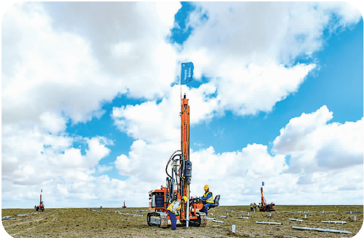
近年来，地处毛乌素沙漠腹地的内蒙古自治区鄂尔多斯市鄂托克前旗，充分利用沙漠腹地富集的光能和风力资源优势，大力发展绿色能源产业。图为8月27日，打桩机在鄂托克前旗一处光伏电站项目建设工地施工。
