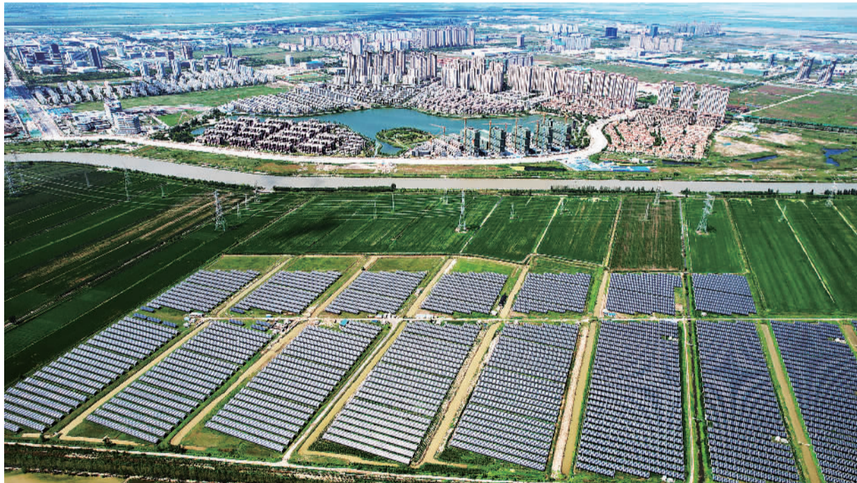
8月30日拍摄的位于江苏省连云港市经济技术开发区朝阳街道内的一处光伏发电项目。 耿玉和摄（人民图片）
