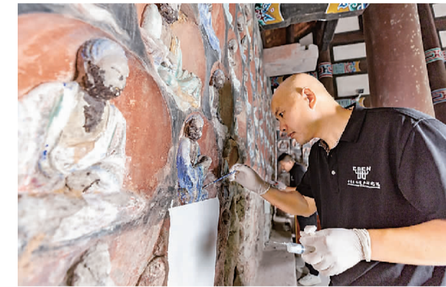
日前，在大足石刻小佛湾摩崖造像保护工程现场，工作人员对石刻造像病害进行处理。 新华社记者 黄伟摄
