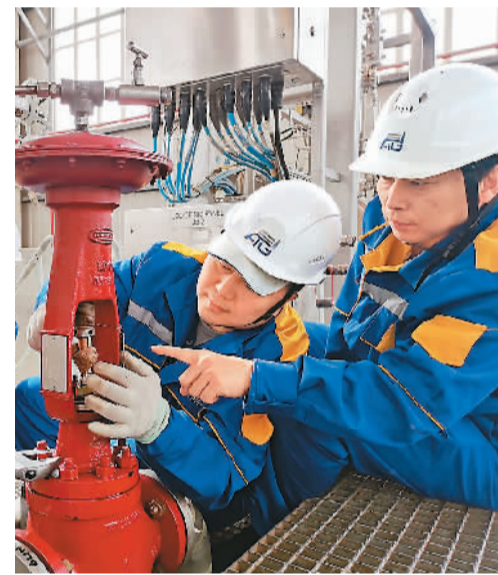
中乌天然气管道合资公司员工开展设备维护作业。
