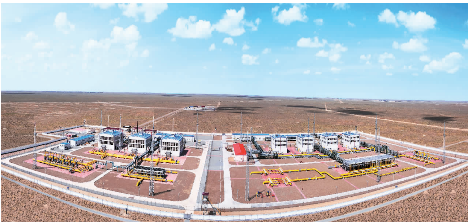
中乌天然气管道合资公司压气站。
