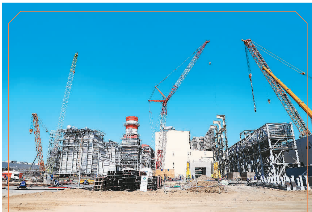
▲锡尔河1500兆瓦燃气联合循环电站项目厂区。
