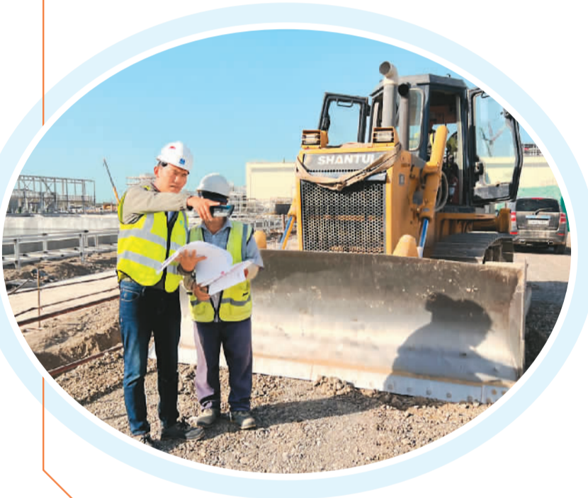
▲高阳（左一）在工程现场。 均为受访者供图
