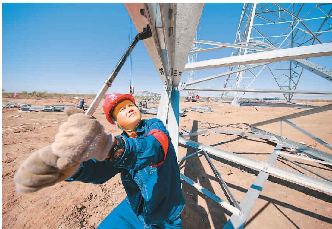
▲在准东—皖南±1100千伏特高压直流工程施工现场，工人在紧固螺栓。
