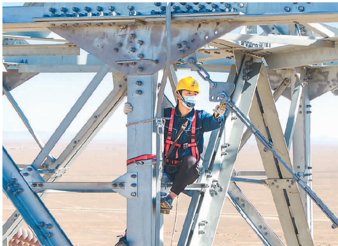
▲新疆送变电乌鲁木齐运检分公司检修小组工作人员，进行铁塔金具消缺。
