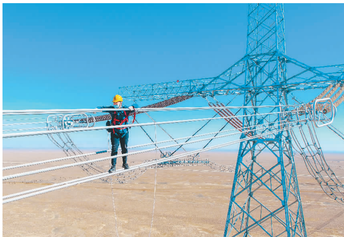
▲新疆送变电线路巡视人员在高空对吉泉输电线路进行检查。
