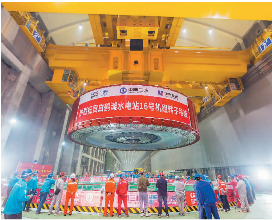
白鹤滩水电站16号机组转子吊装现场。
