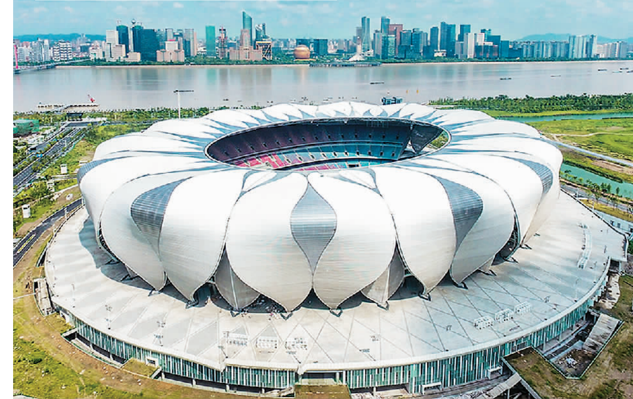
杭州奥体中心体育场 图片来源：杭州亚运会官网
