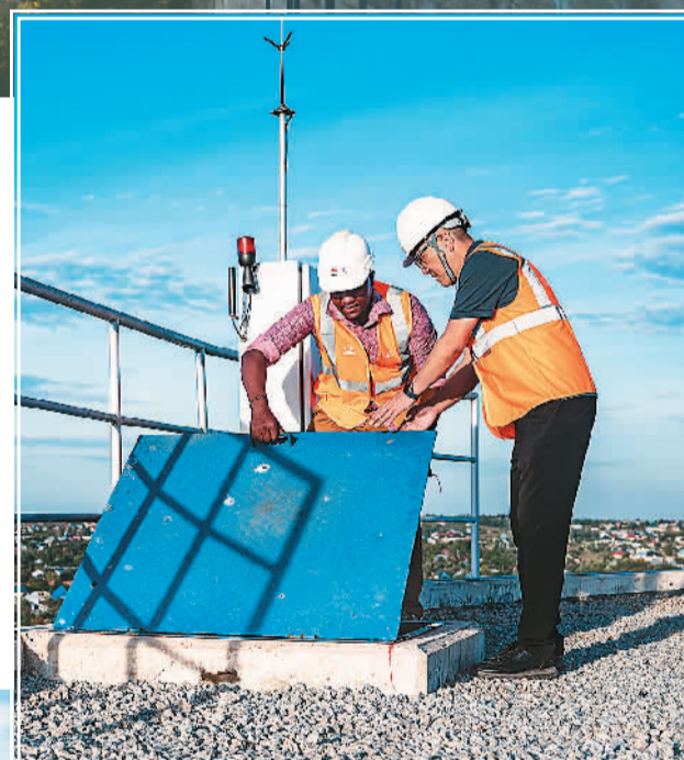
►凯尔文（左）与同事在布斯韦卢检查供水项目高位蓄水池。
