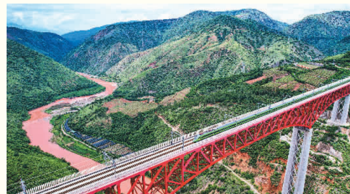
“复兴号”动车飞驰在中老铁路元江特大桥上。 杨紫轩摄
