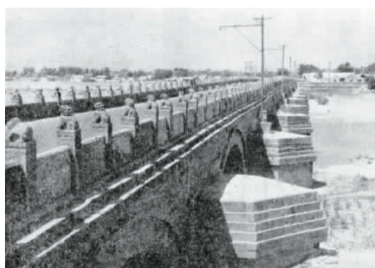
图为20世纪70年代文保专家记录的卢沟桥压面石和分水尖状况。
