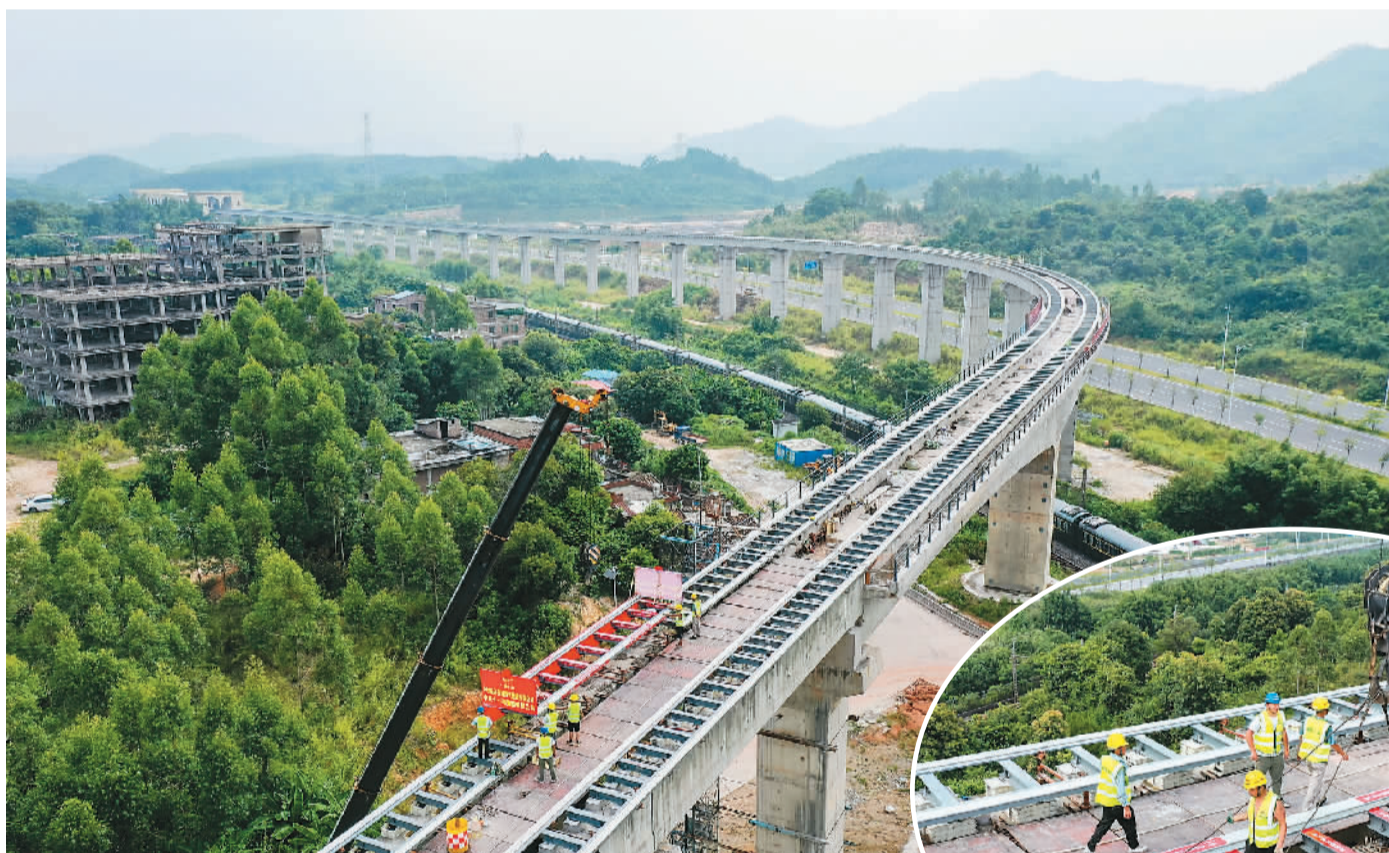
8月10日，中铁十一局建设者将最后一根10米磁浮轨排稳稳铺设在横跨京广铁路的长隆特大桥上，标志着广东首条中低速磁浮线——清远磁浮旅游专线实现轨道贯通。图为施工现场。新华社记者 刘大伟摄
