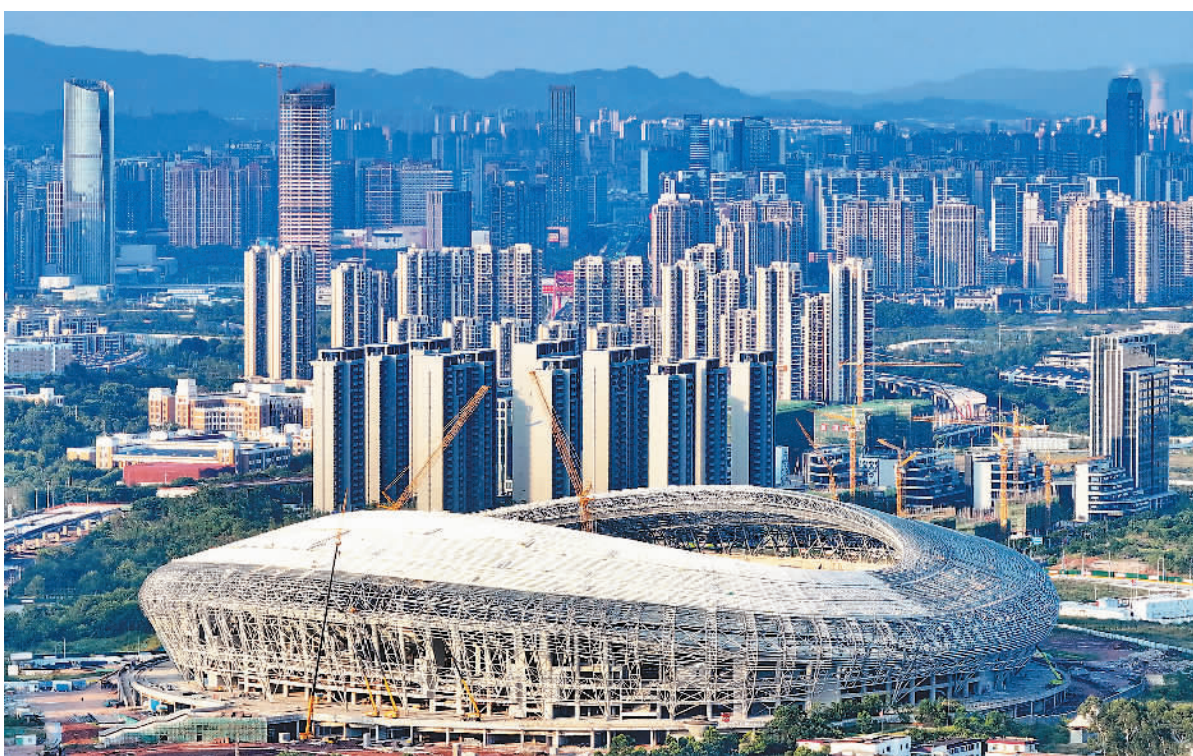
8月5日,江西省赣州市全民健身中心综合体育场建设工地,工人在安装钢结构件和采光棚。场馆建成后,不仅可以满足市民的健身需求,还可以承办各级体育赛事等。
