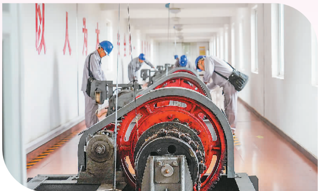
7月31日，工作人员在河北省遵化市上关水库检查泄洪闸起重设备。刘满仓 摄（新华社发）
