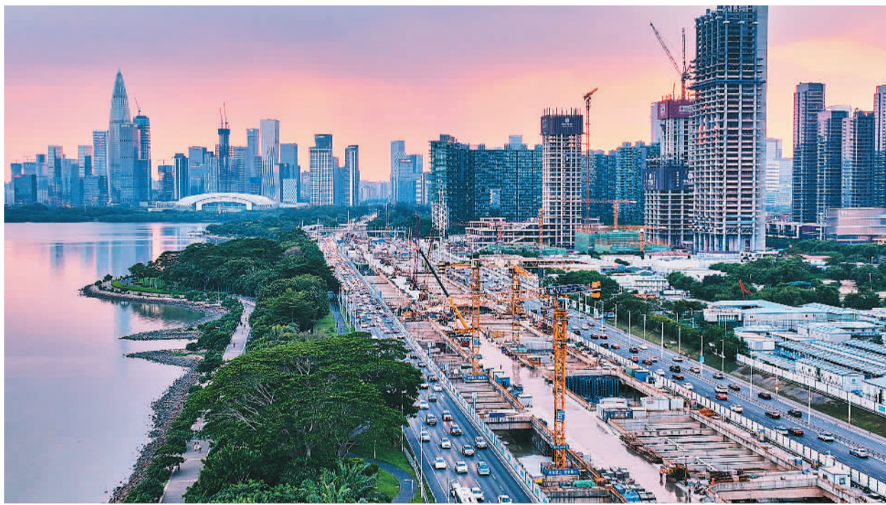
连日来，广东深圳滨海大道综合改造工程项目建设如火如荼。建设者加紧施工，全力以赴确保年底主线高质量通车目标圆满完成。据介绍，该工程项目位于深圳湾畔，地跨南山、福田两区，是深圳市的重点工程。图为施工现场。
