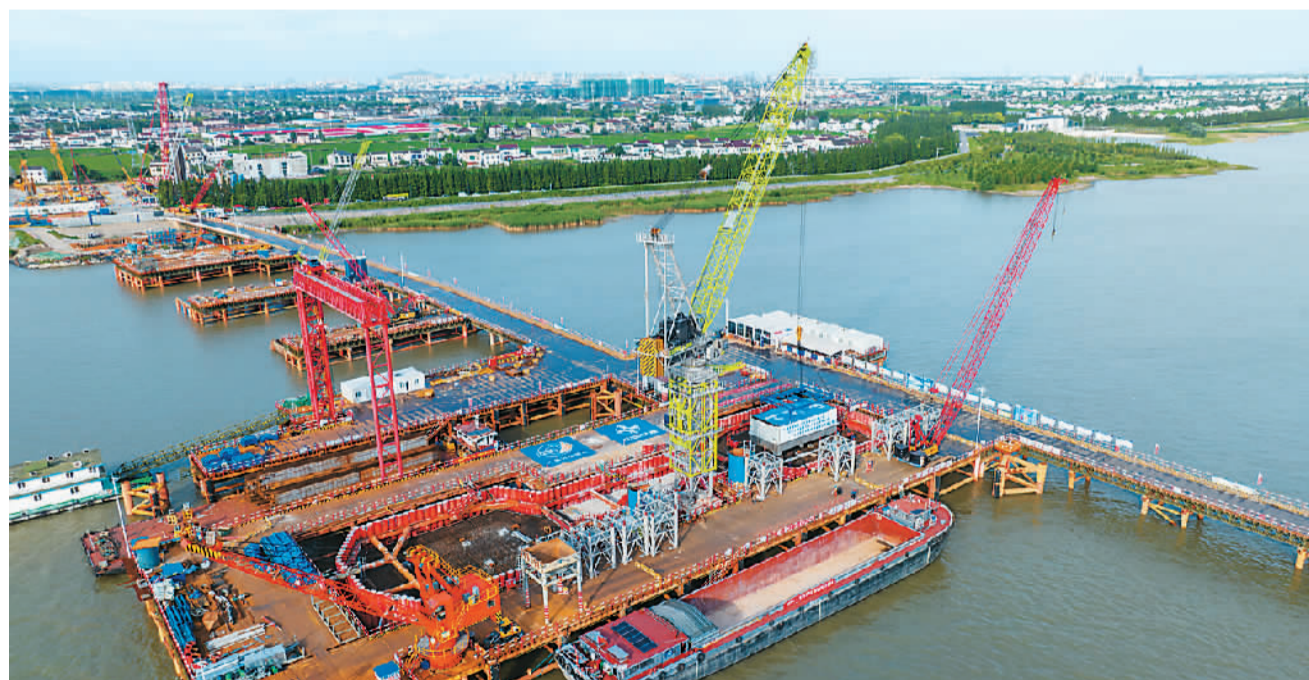
近日，位于江苏省张家港市的张靖皋长江大桥主桥建设进入塔柱施工阶段，该大桥全长约30公里，跨江段长7859米，其中跨度2300米的南航道桥为世界最大跨度桥梁。图为由中交二航局施工的大桥南航道桥辅塔首节段钢塔吊装现场。
