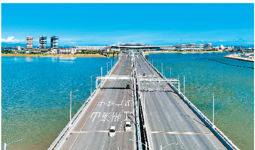
图为近日车辆在港珠澳大桥上行驶。梁建华摄（新华社发）
