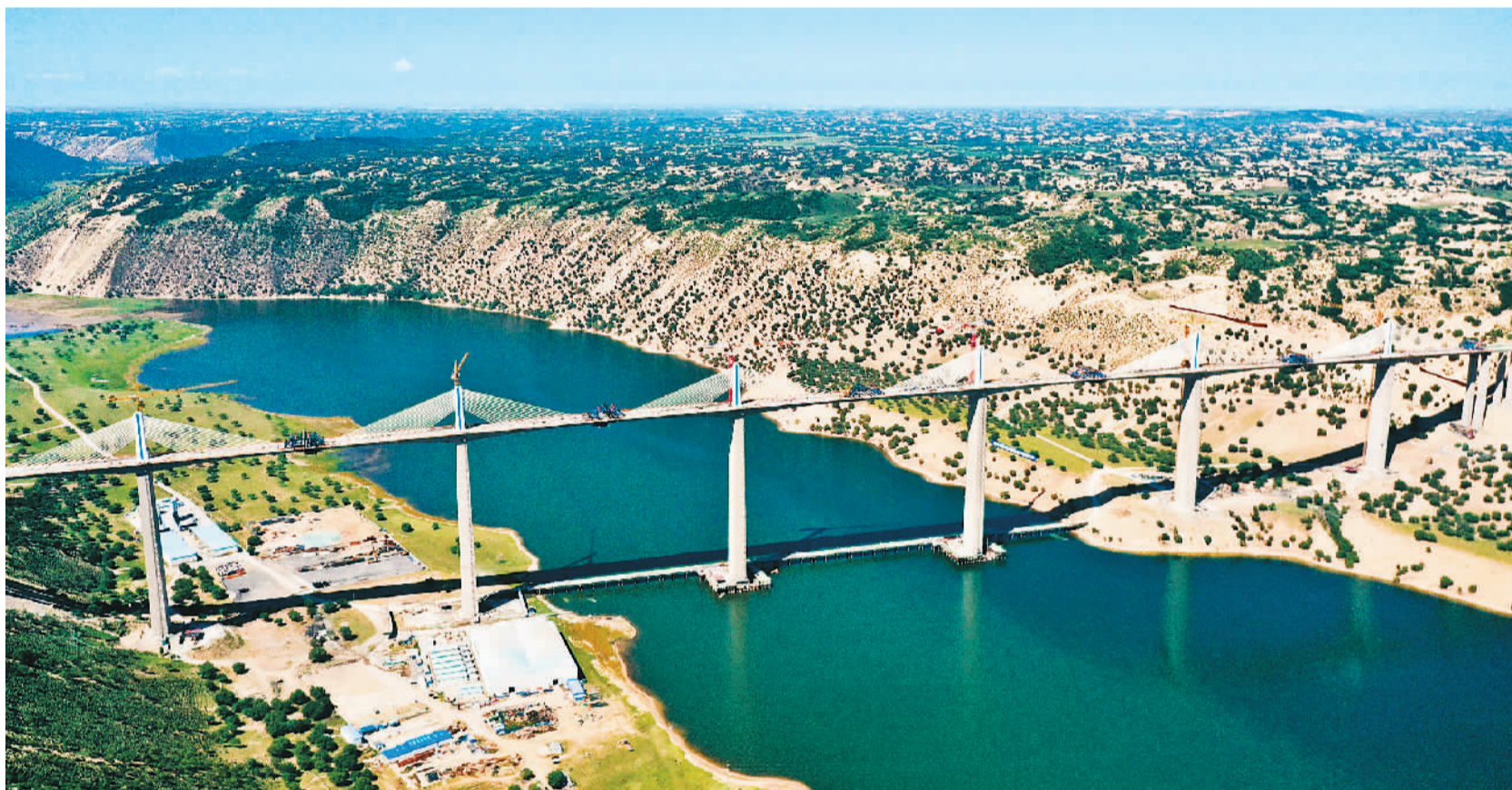
7月25日，世界最高、跨径最大的PC(预应力混凝土)梁多塔斜拉桥西拉沁特大桥合龙。西拉沁特大桥是内蒙古自治区重点工程项(棚)乌(兰布统)高速公路的重要控制性工程，桥长2064米，主桥6个索塔高度均为38米，墩梁塔总高210米，不仅是世界墩身最高、跨径最大的PC梁多塔斜拉桥，也是目前世界上首座在风积沙峡谷区建设的大型桥梁。项目于2019年10月全线开工建设，全桥顺利完成后将转入桥面施工作业，预计今年10月完工。图为西拉沁特大桥合龙现场。吴勇、罗杰、应世明摄影报道
