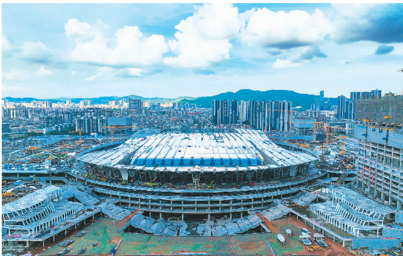
广州白云火车站是全国铁路规划中的重要项目，是广州铁路枢纽规划“五主四辅”客站中的主要客站之一。该站建成运行后，将助力形成“轴带支撑、极轴放射”的多层次铁路网络，逐步构建和完善“轨道上的大湾区”。图为日前拍摄的白云火车站建设现场。 陈志强摄（人民视觉）
