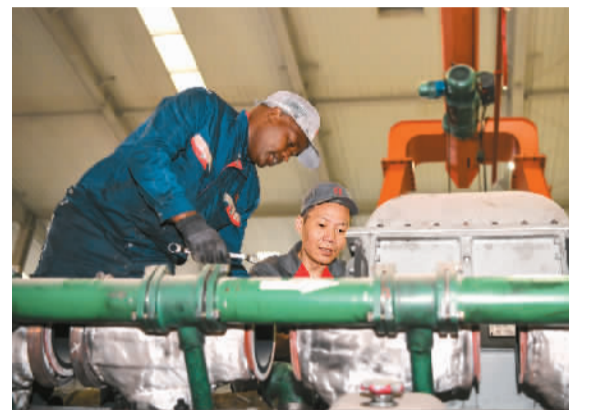
图为7月4日，中国中车驻肯员工和肯方员工在蒙内铁路机车维保车间工作。
