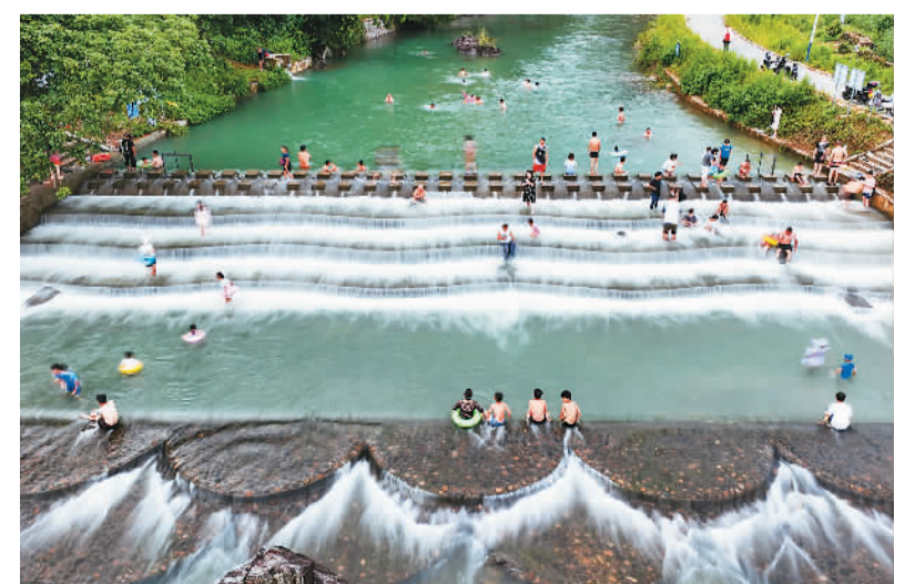
广东省广州市增城区派潭镇背阴村利用清泉溪流的天然环境,打造出避暑纳凉好去处。图为7月19日,游客在背阴村溪流中玩水,畅享清凉。 卜伟峰摄(人民视觉)
