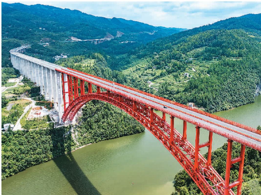
七月十日, 贵州省德江至余庆高速公路全线建成通车。德余高速公路建成通车对完善当地高速公路路网结构、推动武陵山集中连片区域经济社会发展具有重要意义。图为当日, 车辆行驶通过德余高速公路乌江特大桥。新华社记者 陶亮 摄
