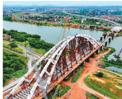
正在建设中的江西省赣州市创业大桥, 是横跨章江的一座特大桥, 大桥建成后有助于连接赣州章江南北组团和高铁、机场片区, 提升城市空间转换效率。图为7月5日, 创业大桥钢结构拱架施工现场。朱海鹏摄(人民视觉)
