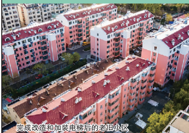
完成改造和加装电梯后的老旧小区
