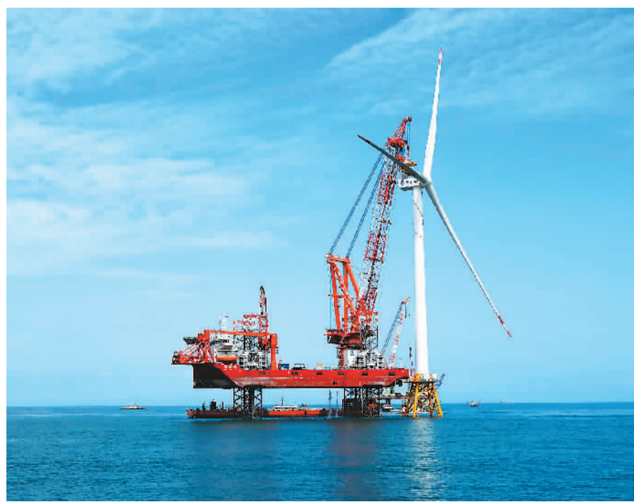
6月28日,全球首台16兆瓦海上风电机组在三峡集团福建海上风电场成功吊装。这标志着中国海上风电高端装备制造能力、深远海海上风电施工等全产业链实现整体提升,达到国际领先水平。
