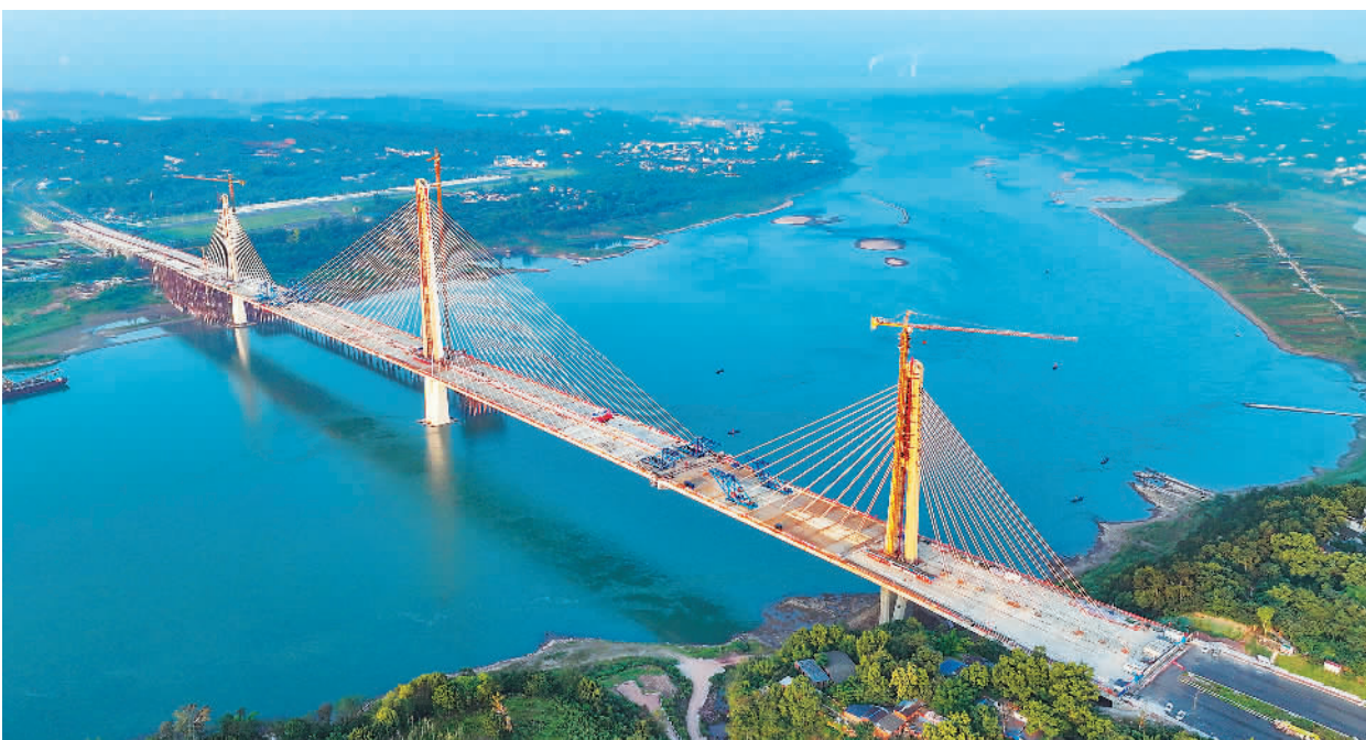
6月26日，四川省泸州市长江六桥主桥顺利合龙，该桥是泸州城市二环线的重要控制性工程，预计今年底将具备通车条件。刘学懿摄（人民视觉）
