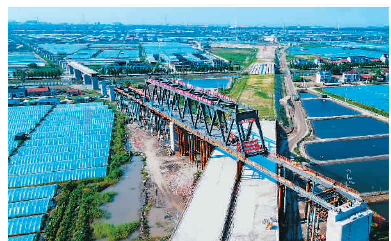
日前，由中铁上海工程局承建的通州湾新出海口洋吕铁路完成跨洋通高速特大桥简支钢桁梁拖拉到位、洋口运河特大桥钢桁梁整体吊装作业，为洋吕铁路9月底全线通车打下坚实基础。洋吕铁路线全长约85公里，建成后将有有效串联江苏南通沿海各港区，有利于打造通州湾长江集装箱运输新出海口集运体系。 袁铭摄（人民视觉）
