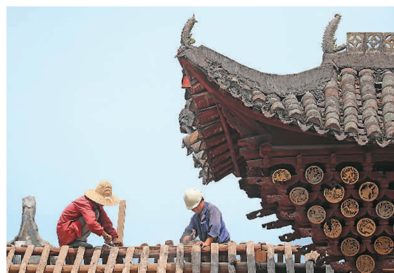
▲近年来，江西省吉安市泰和县积极开展古村古建筑修缮保护工作，延续历史文脉，增强公众对传统文化遗产的保护意识。图为近日，泰和县南溪乡匠人正在修缮古建筑。邓和平摄(人民图片)
