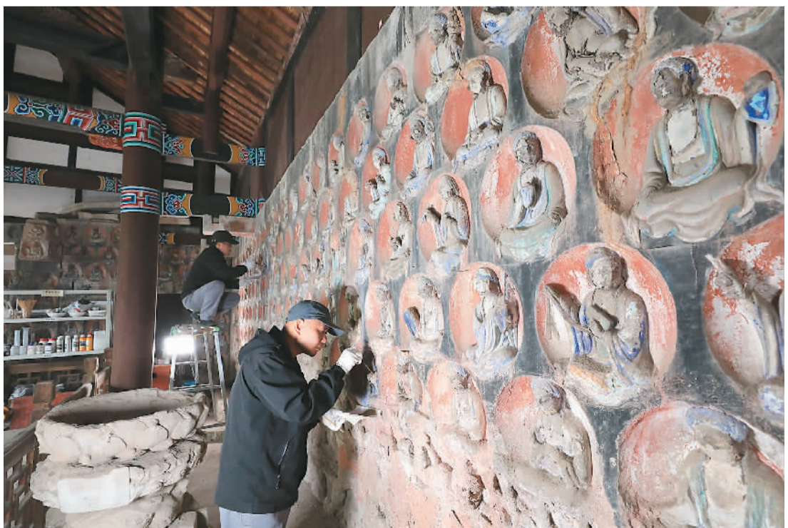
▲2023年3月31日，大足石刻小佛湾修复现场，修复人员正在对石窟造像进行清理。小佛湾石窟保护修复工程于2019年6月启动，目前已完成整个工程量的六成。黄舒摄(人民图片)
