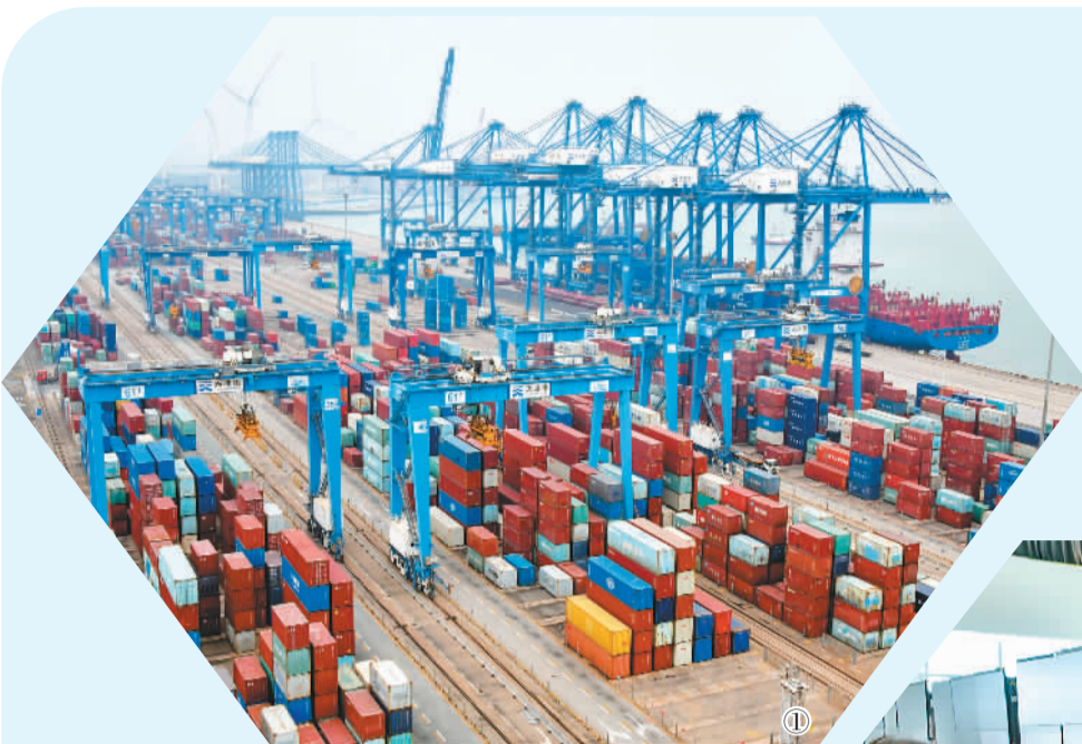
图①：图为天津港北疆港区C段智能化集装箱码头。
