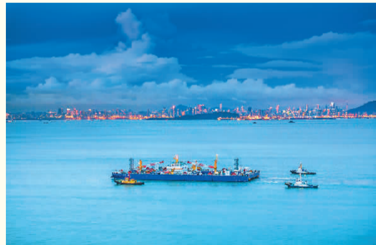
图为最后一个管节和最终接头正在浮运。 苏振飞摄
