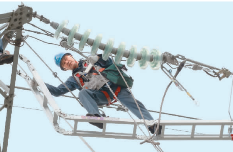
日前，南方电网贵州兴义供电局启动“迎峰度夏”保供电工作，重点对110千伏、220千伏高压输电线路开展检查维修，保障电网安全运行。图为维修人员在110千伏输电铁塔对输电线路设备进行检查。 森木摄
