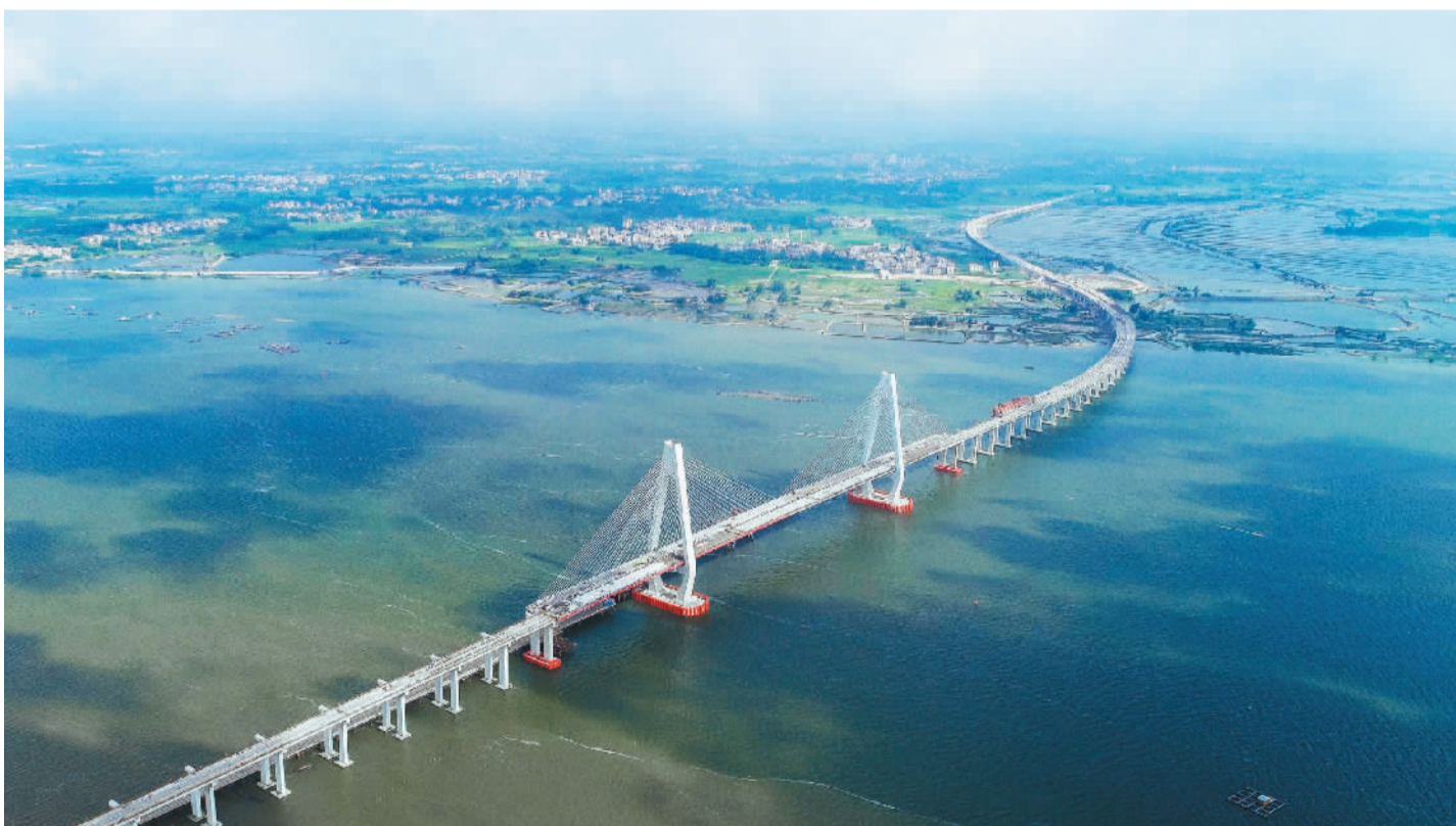
广东省湛江市环城高速连接湛江吴川黄坡镇和南三岛，是一条海岛高速通道。中铁大桥局承建的鹭洲大桥目前已进入最后冲刺阶段，大桥全长562米，桥梁主跨300米，建成通车后将南三岛海岛旅游发展奠定交通基础。
