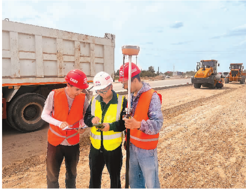
图为张程荣（中）带领乌兹别克斯坦籍测量员进行测量放样工作。徐成涛摄
