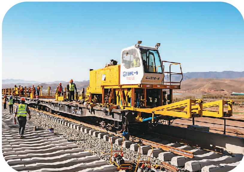
5月26日，在甘肃省武威市天祝藏族自治县新建兰州至张掖三四线铁路(简称兰张三四线铁路)下河东特大桥施工现场，随着一组500米长钢轨铺设在道床上，兰张三四线铁路兰武段铺轨工程正式开始。赵世鹏摄(人民视觉)
