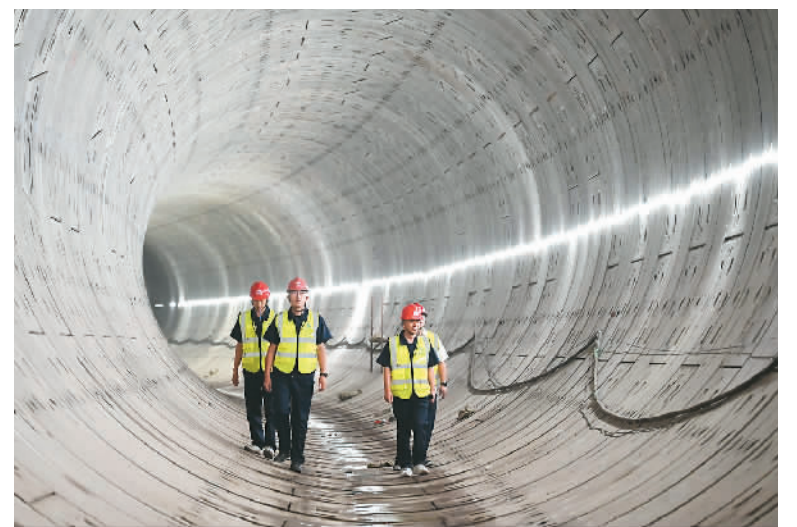
长三角一体化重点工程——苏州地铁7号线首个管段主体工程日前完工，标志着苏州地铁7号线建设取得重要进展。线路建成后，将与已运营的4号线支线贯通运营，沿线串联高铁苏州北站、高铁新城等重要功能中心和枢纽地区，对促进苏州城市资源整合和经济社会发展起到积极作用。图为中铁二十二局苏州地铁7号线项目工作人员在盾构区内巡检。宋 强摄(人民视觉)
