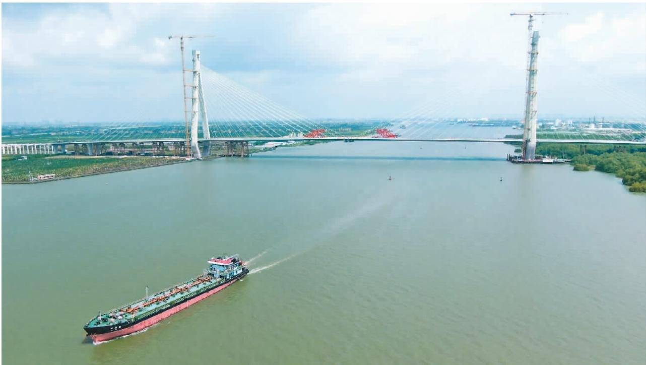
5月21日，由中铁大桥局承建的南中高速洪奇门特大桥顺利合龙。洪奇门特大桥全长1126米，为主跨520米的双塔双索面钢箱梁斜拉桥，是南中高速项目的关键控制性工程。南中高速公路是粤港澳大湾区核心区域互联互通的特大型桥梁工程
