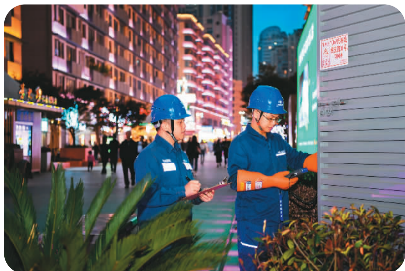
“五一”节后,贵州省贵阳市夜经济发展潜力不断释放,青云市集迎来众多游客。图为日前南方电网工作人员在青云市集运用红外测温仪对电力设备进行检查,确保供电安全。李波摄
