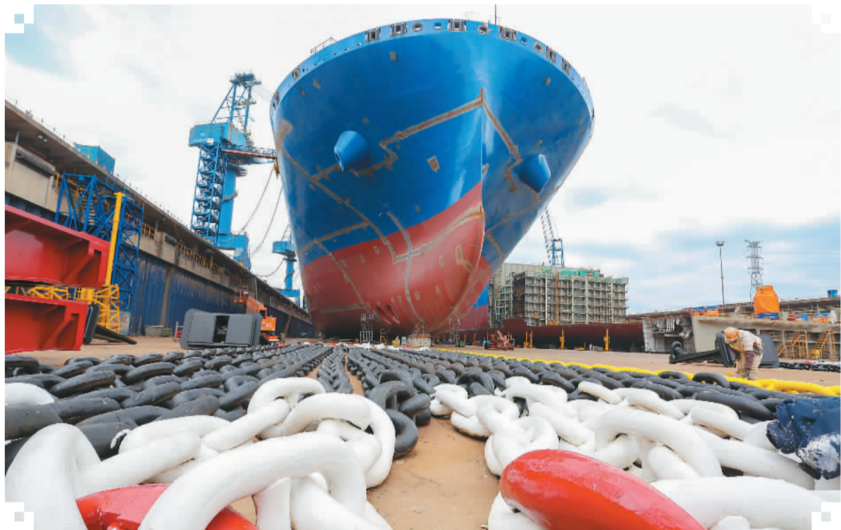
位于江苏省扬州市江都区的扬州中远海运重工有限公司是中国远洋海运集团在江苏省建立的造船基地,客户除国内主要航运公司外,还覆盖希腊、法国、挪威等国家主流航运公司。目前,该公司开足马力抓生产,在手订单共计41艘,2023年公司全年计划交付新船19艘。图为工人在施工作业。 朱桂根摄(新华社发)
