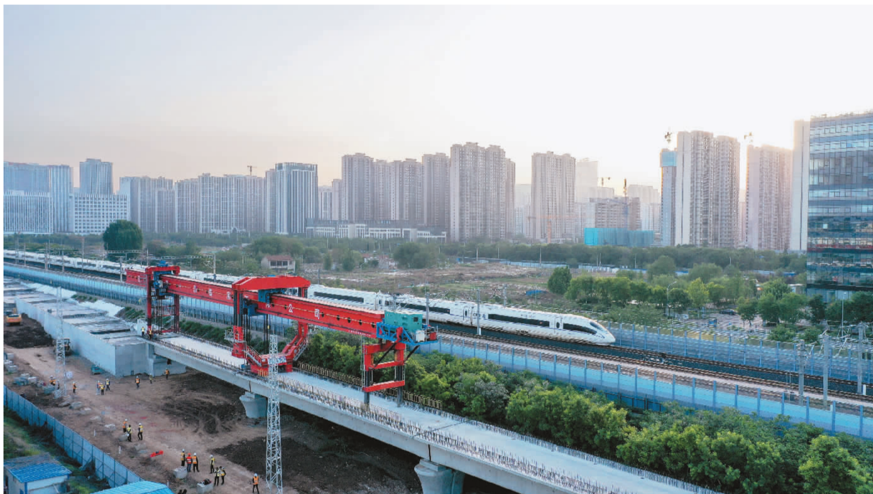
五月七日, 济(南)郑(州)高铁山东段最后一根箱梁在中铁十局站前1标顺利架设完成, 至此, 济郑高铁山东段全部箱梁架设工作, 全面转入铺轨阶段。 据悉, 济郑高铁是国家“八纵八横”高铁网的重要组成部分。项目通车后, 济南到郑州的通行时间会缩短至一个半小时, 将成为中原城市群与山东半岛城市群间的快速客运通道。 图为工作人员正在完成箱梁架设作业。 新华社记者 郭绪雷摄
