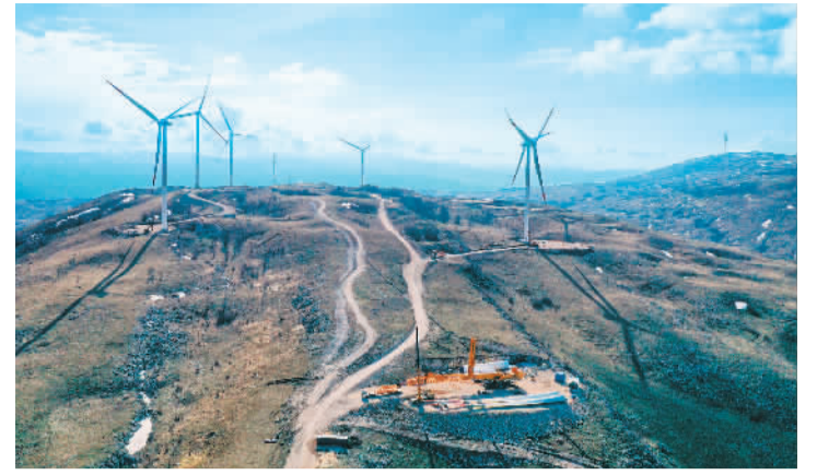
波黑伊沃维克风电场施工现场。中国电力建设集团供图（新华社发）
