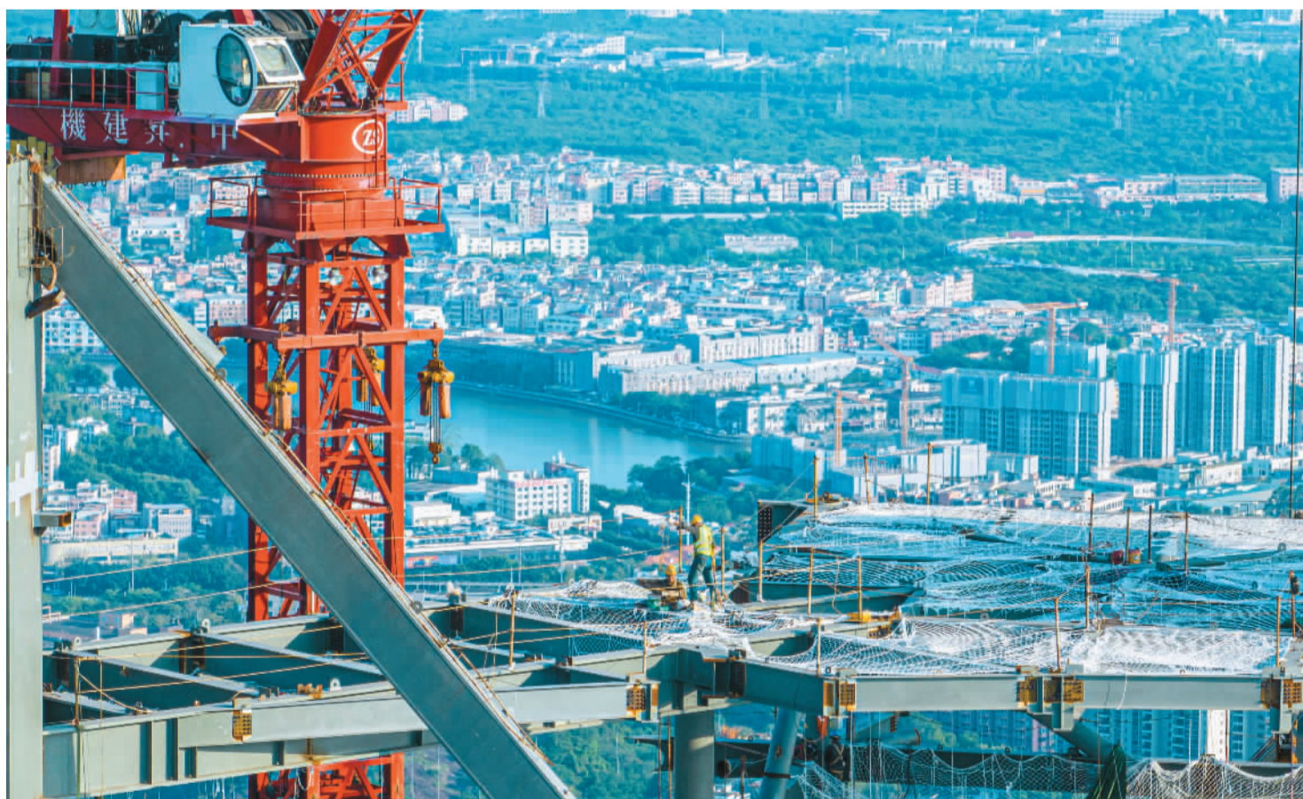
近日，广东省广州市琶洲人工智能与数字经济试验区吊塔林立，建设者正在加紧施工，现场忙碌有序。
