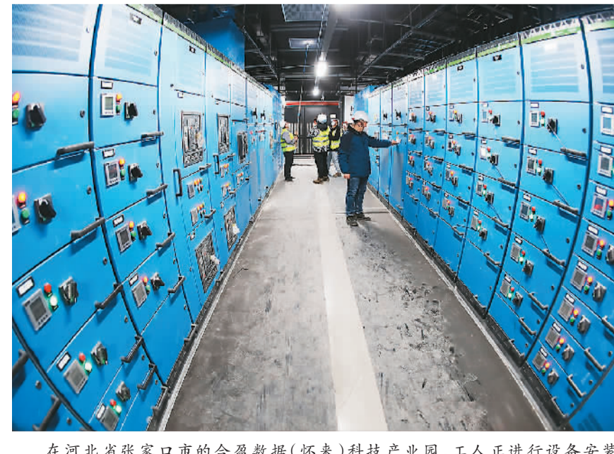
在河北省张家口市的合盈数据(怀来)科技产业园，工人正在进行设备安装调试。武殿森摄(人民图片)
