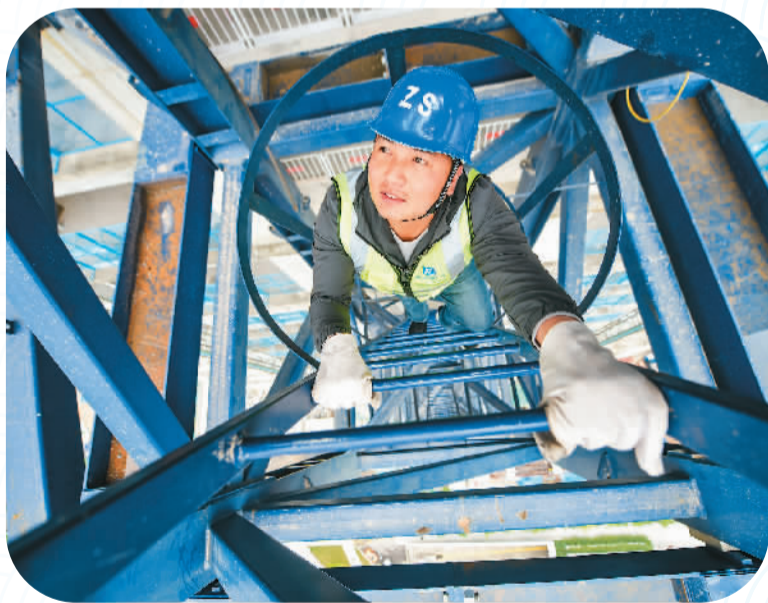
▲ 在中建八局二公司承建的山东省济南CBD中央广场18#地块项目上，建设人员登上动臂塔吊开始作业。 孙裕泽 刘 松摄
