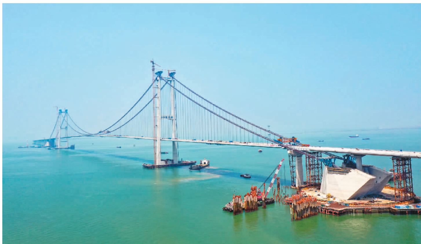
4月28日上午,国家重大工程深中通道伶仃洋大桥成功合龙,这意味着该项目桥梁工程全线合龙。深中通道的桥梁工程长约17公里,其中伶仃洋大桥为项目关键控制性工程之一,全长2826米,主跨1666米,主塔高270米,桥下通航净空高度为76.5米,是世界最大跨径的海中钢箱梁悬索桥和世界通航净空最高的海中大桥。伶仃洋大桥于2018年9月开工建设,由中交二航局、保利长大等企业承建。据了解,深中通道计划于2024年建成通车。王鑫洲、杜才良摄影报道
