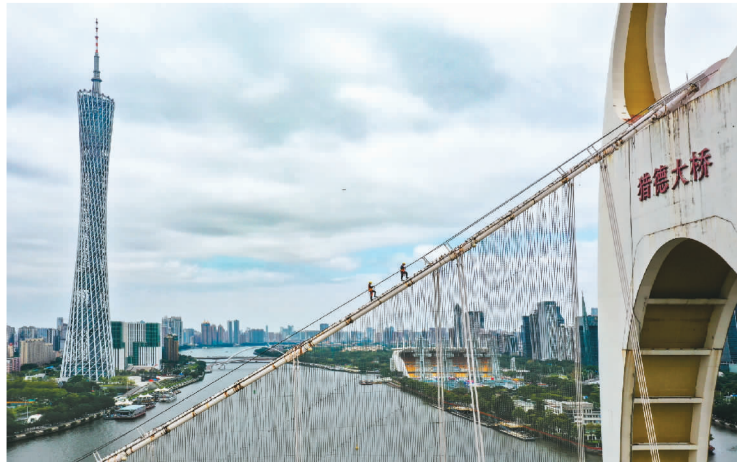
4月26日，广州猎德大桥工作人员对悬索桥主缆开展检修维护工作，确保桥体缆索结构安全。猎德大桥连接广州市天河区与海珠区，纵跨珠江北干流前航道，是当地标志性建筑之一。陈志强摄（人民视觉）
