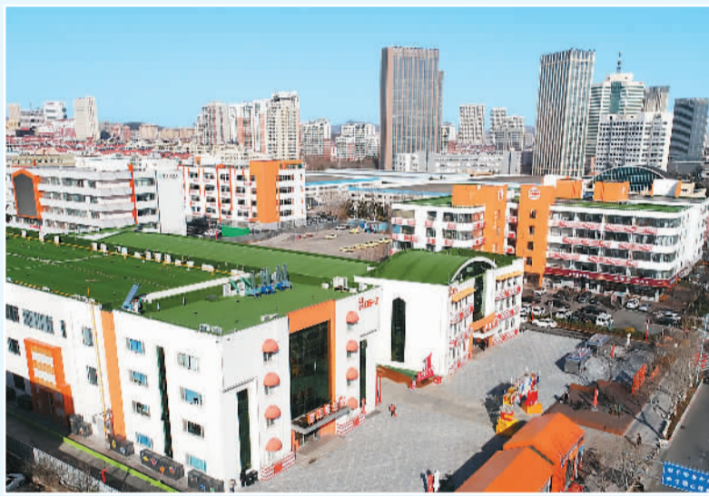
山东自贸试验区青岛片区成立以来，持续对区域内的老厂房、老建筑进行升级改造，在保留老厂房原有风貌的基础上，又导入时尚活力的新产业、新业态，打造融合跨境电商、创新商业、文化展示、科创办公以及工业旅游等要素的智慧型园区，让老厂房重新焕发出勃勃生机。图为由老厂房改建而成的“闻创驿”智慧园区。 张进刚摄（人民视觉）
