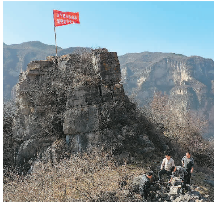
▲ “立下愚公移山志 誓把荒山变金山”的旗子飘扬在修路现场。
