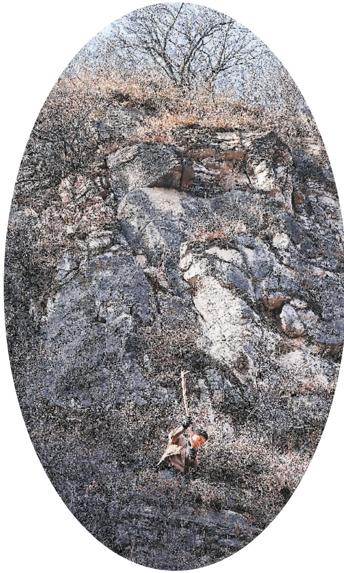
▲ 青龙峡村村民申森在清理路基上的杂物。 ▶ 村民挑着石块运往修路现场。 ▼ 村民在修路间隙歇脚休息，补充体力。
