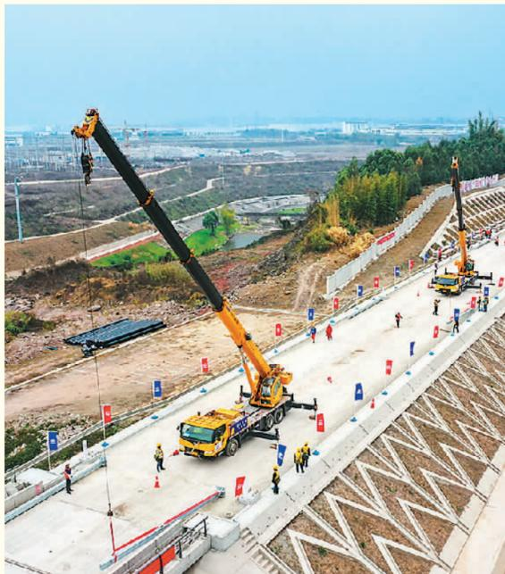
施工人员在位于重庆市永川区的渝昆高铁施工现场架设接触网杆。
