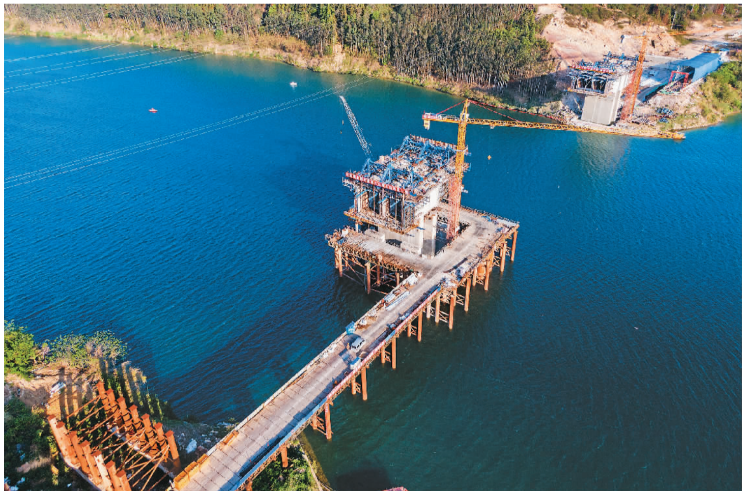
广西壮族自治区柳州市融水苗族自治县融水三桥是当地重点民生工程之一,主桥长395米,引桥长120米,桥宽24米。大桥建成通车后将完善当地路网结构,助力乡村振兴。图为建设中的融水三桥。 龙 涛摄(人民视觉)
