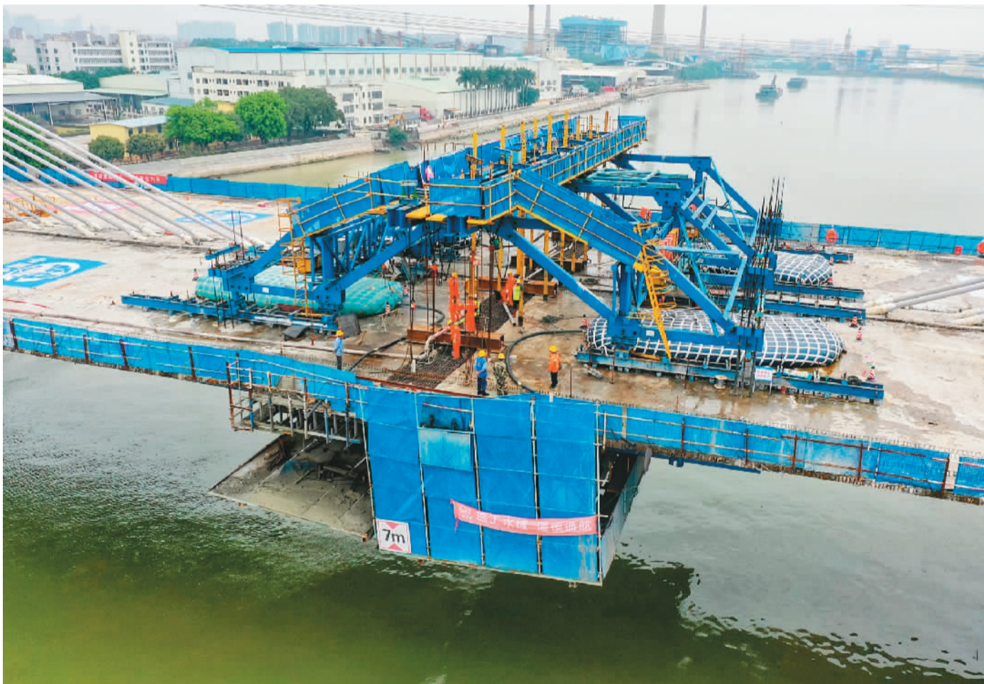
近日，由中铁四局承建的东莞樟马特大桥主跨顺利合龙。该桥是广东东莞中（堂）洪（梅）路工程控制性节点，大桥全长686.5米，横跨中堂镇倒运海水道。中洪路工程位于东莞市西北部，全长约19.4公里，通车后将极大改善东莞水乡片区的交通出行条件，实现区域交通一体化。图为东莞樟马特大桥主跨合龙施工现场。
